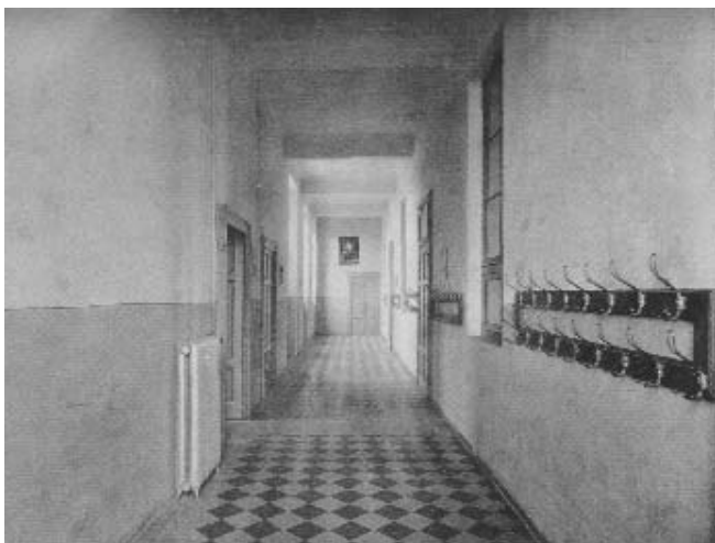
Foto n. 13 - Corridoio delle scuole Elementari
